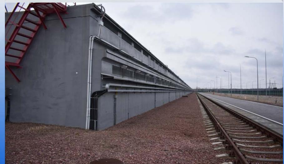
Módulos de almacenamiento en hormigón para combustible gastado de la ISF-2
