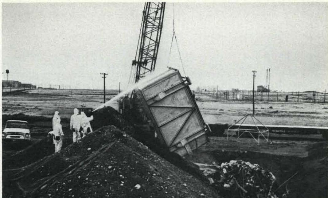
Déchets de faible contamination radioactive chargés dans un conteneur pour être ensuite enfouis dans une fosse, à l'usine de Hanford de la Commission de l'énergie atomique. L'aspersion d'eau froide à éviter l'entraînement de contamination par le vent ... Battelle-Northwest
