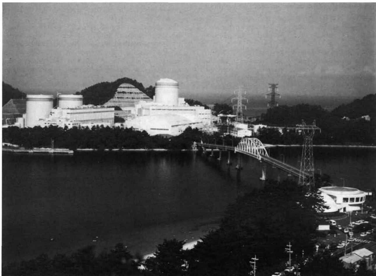
Centrale nucléaire Mihama (Japon). (Photo: Kansai Electric Power Co.)
