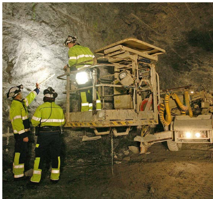
Exploración subterránea para demostrar la viabilidad de la disposición final geológica profunda de desechos de actividad alta (Fotografía: Posiva Oy (Finlandia))
