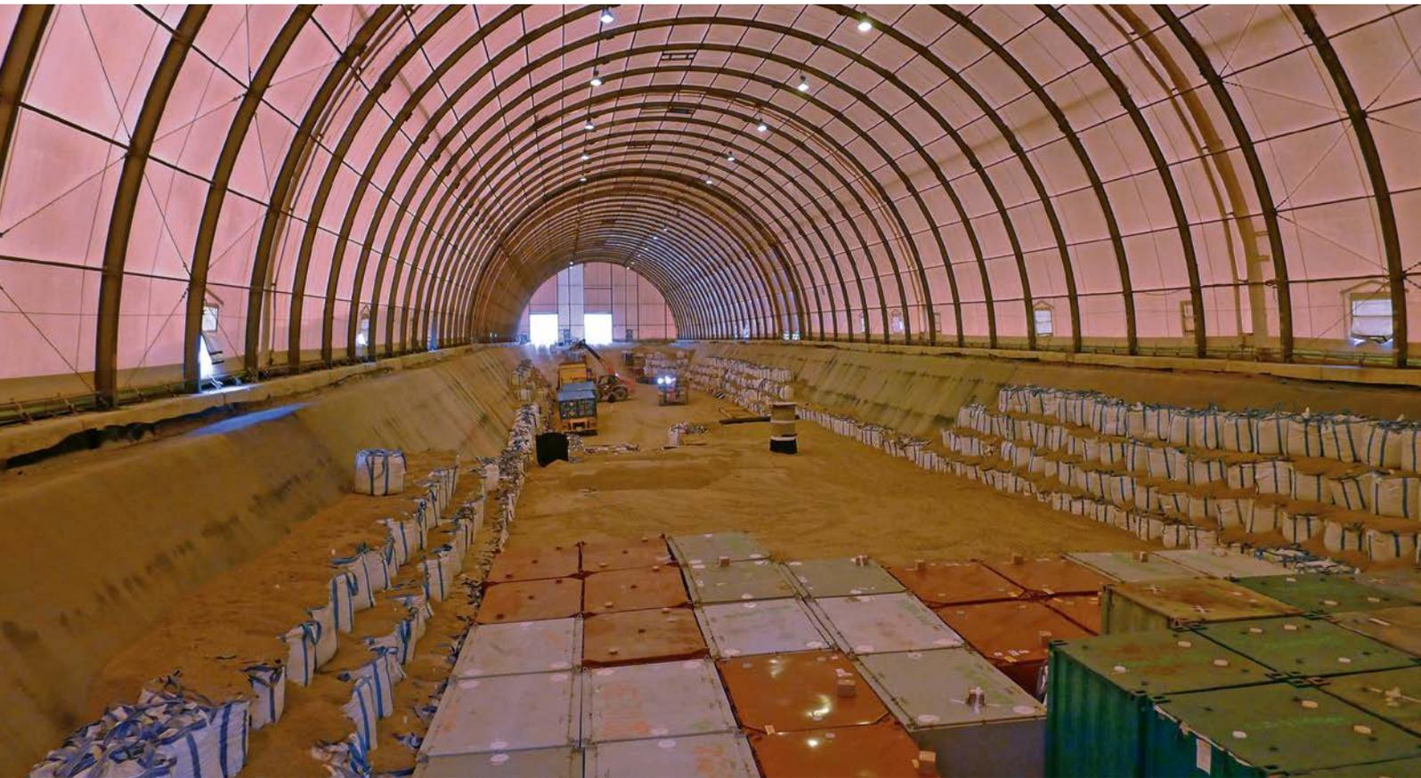
Zanja para la disposición final de desechos de actividad muy baja en la instalación de disposición final del CIRES (Francia)
