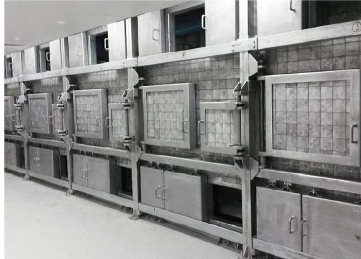
**6** Des murs de plomb et des portes blindées ont été installés pour assurer la sûreté et la sécurité de la zone chaude de l'installation où seront les matières radioactives. C'est dans cette zone que les matières radioactives brutes sont placées et c'est de là que sortent les produits finis (c'est-à-dire les pharmaceutiques) après la transformation des matières brutes dans les cellules chaudes.
