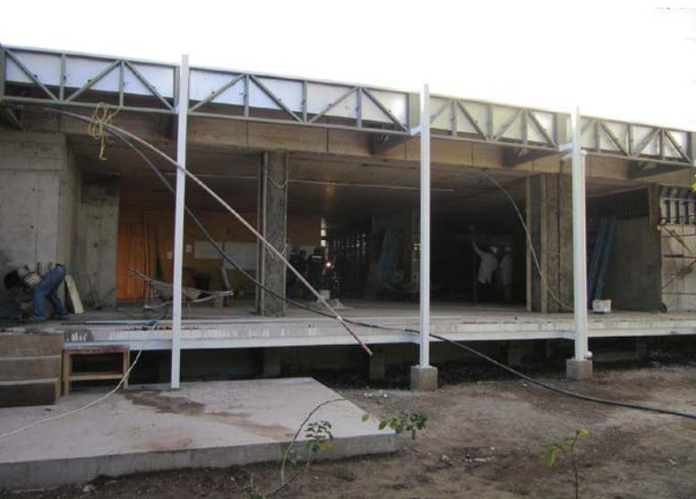
**3** Le bâtiment a été partiellement démolé pour construire de nouveaux murs et des renforcements de blocs capables de supporter le poids des nouvelles cellules chaudes. Une société spécialisée a été recrutée pour construire les piliers en béton. Ce stade des travaux comprenait aussi l'assemblage d'une structure de soutien pour les briques de plomb.
