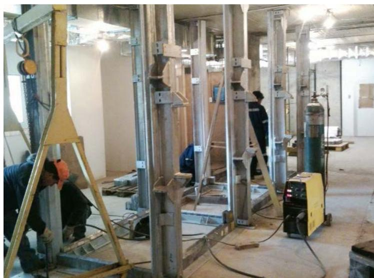
**4** La structure de soutien des cellules chaudes était constituée de plaques d'acier soudées et fixées ensemble avec des boulons puis arrimées au sol. Les murs internes et externes des cellules chaudes ont été fabriqués avec des briques de plomb. Le plomb est un matériau prisé pour la construction de cellules chaudes en raison de sa densité élevée et de son aptitude à bloquer les rayonnements nocifs.
