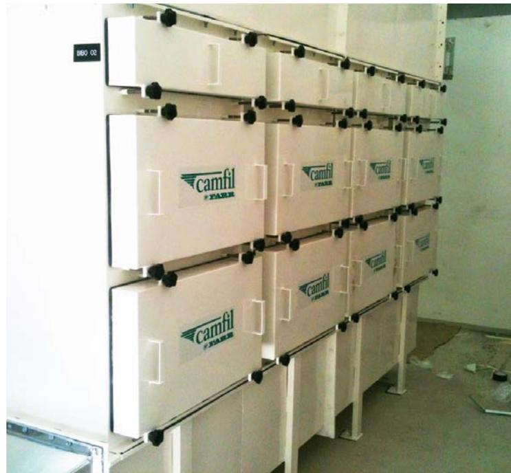
**8** Un système sophistiqué de ventilation avec des préfiltres, des filtres à air à haute efficacité (HEPA) et des filtres de charbon actif a été installé avec les nouvelles cellules chaudes et conçu pour assurer une double filtration afin d'améliorer la sûreté.
