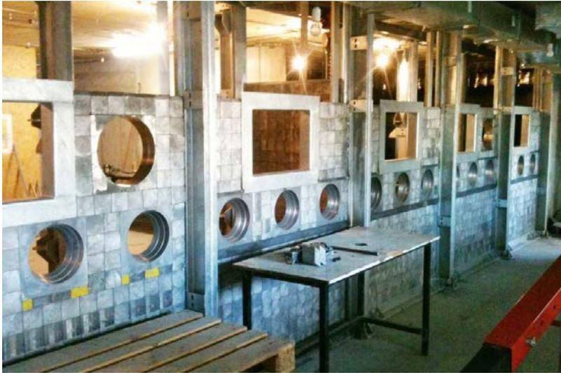
**5** Les cellules chaudes servant à produire des pharmaceutiques au technétium 99m et à l'iode 131 ont été dotées de vitres blindées et des cadres imbriqués pour le montage des télémanipulateurs. Les fenêtres et les télémanipulateurs ont été fournis par l'AIEA et installés par des techniciens qui travaillaient en même temps que le personnel de la Commission chilienne de l'énergie nucléaire (CCHEN).
