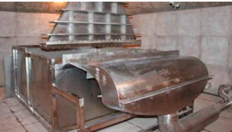
**La cámara de barrido con haces de electrones es el lugar en que las aguas residuales se irradian con haces de electrones de alta energía.**
